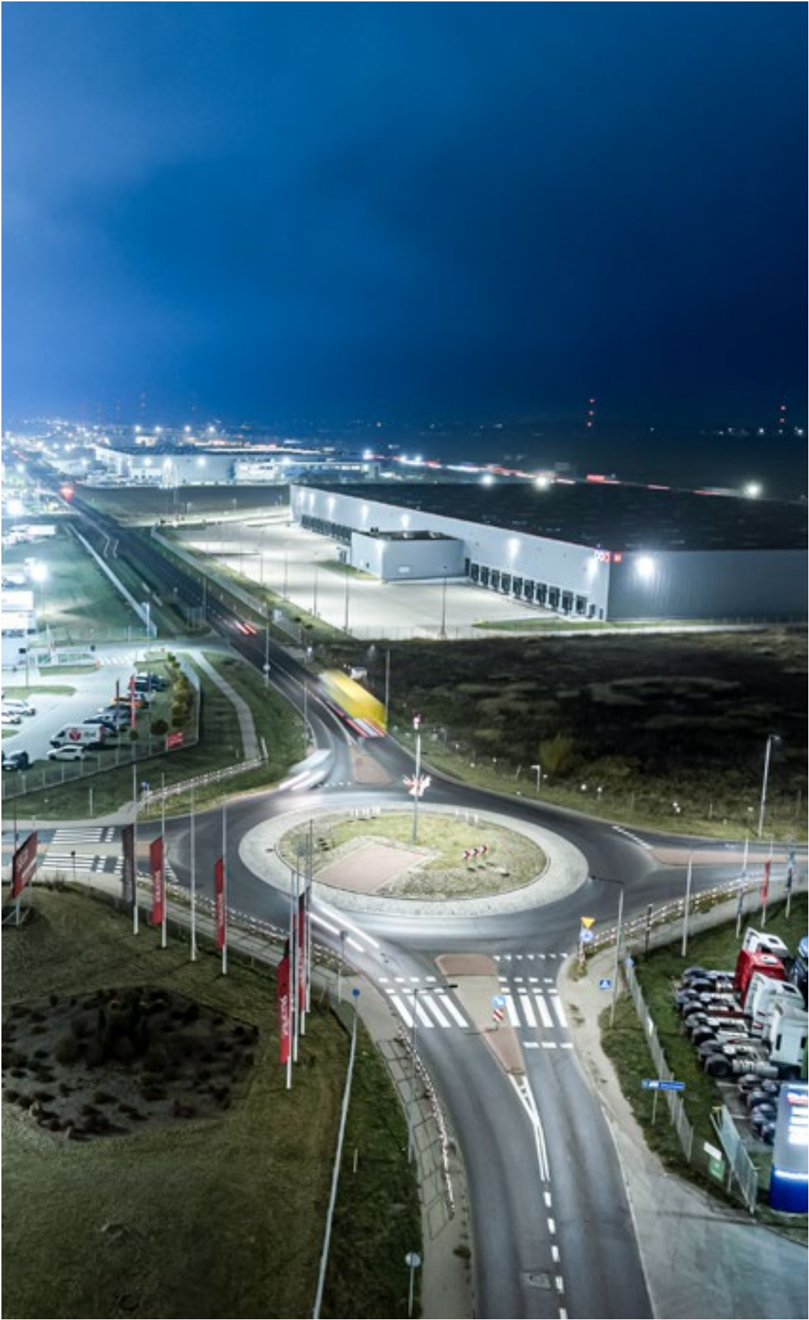
Zastosowanie opraw Astra LED Alu
